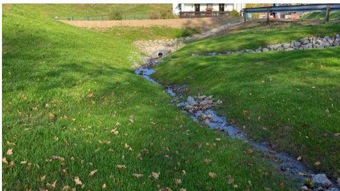
So sieht das Resultat der umgesetzten Maßnahme aus – auch das Bild liegt im System ab
